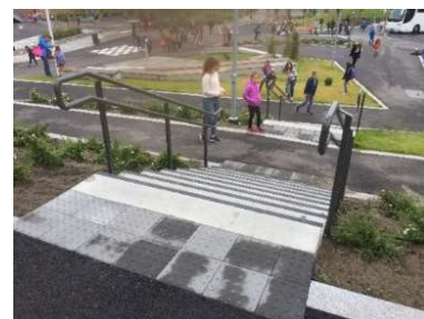
Trapp med farefelt, oppmerksomhetsfelt, markering av trappeneser og håndløpere.
