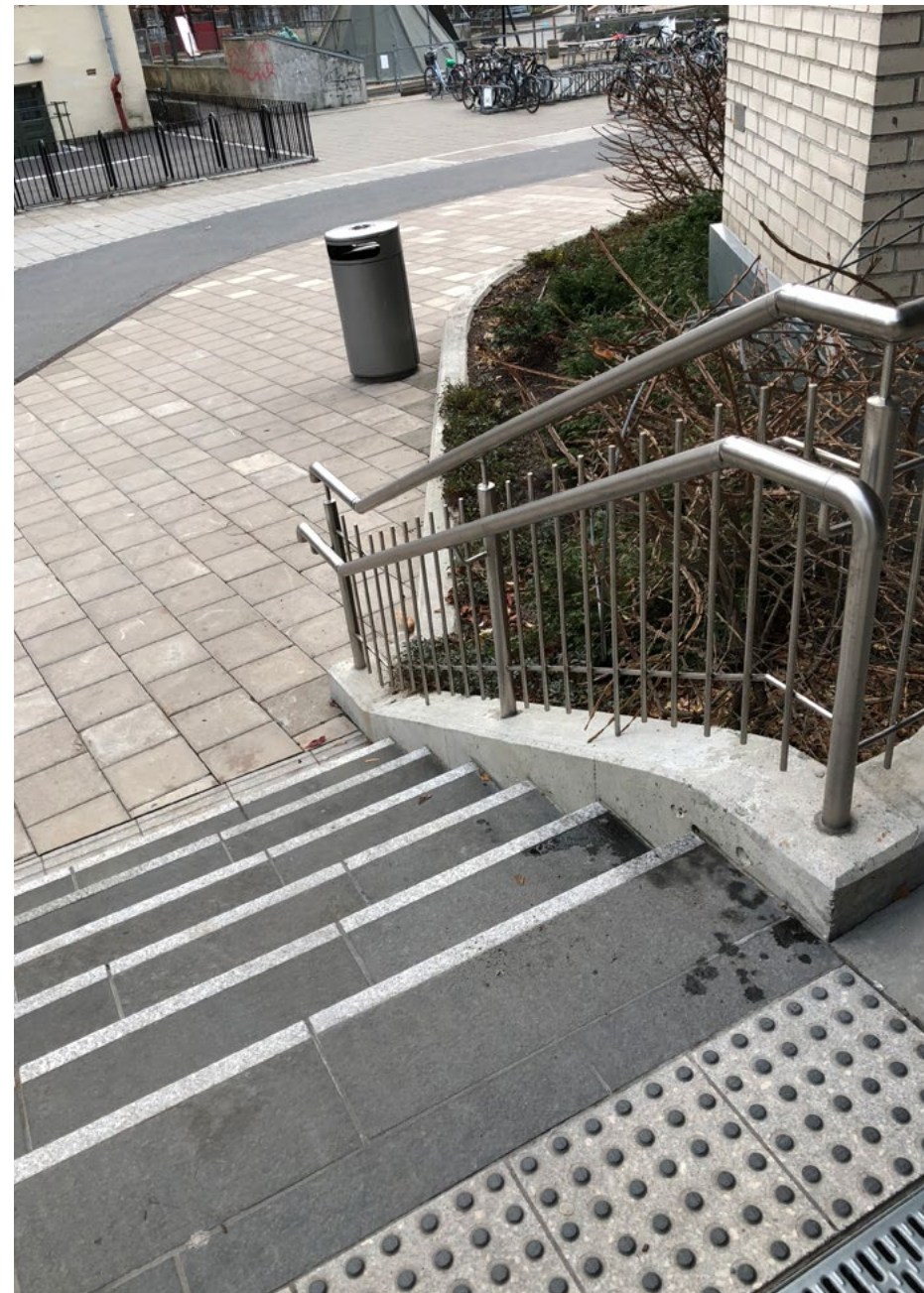
Trapp med taktilt og visuelt farefelt, kontrastmarkering på trappeforkant, oppmerksomhetsfelt og håndløper.
